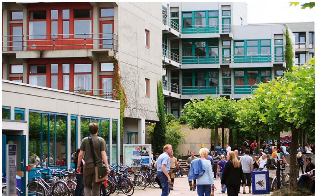
► Teile des Gebäudebereichs 23. Hier wurden im November 2011 im Rahmen von Umbaumaßnahmen erhöhte PCB-Werte festgestellt. Rektorat und Verwaltung leiteten umgehend eine Untersuchung ein. (Foto: Jörg Reich)
